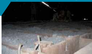
Vue sur amiante libre en plénum logement gardien
